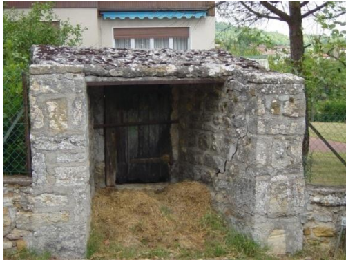
Le puits du chemin du Puits et son double accès , du côté de la voie publique et du côté propriétaire
