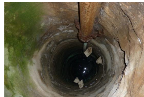
Intérieur du puits du Vieux Bourg de Saint Didier . Il est intégré dans le mur extérieur d'une maison .
