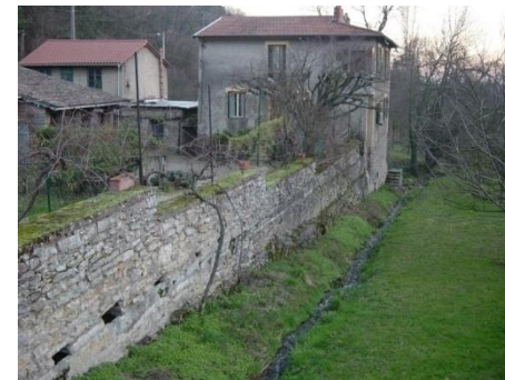
Le moulin de la source d'Arche au bas du chemin des Barres : ici on écrasait les cerneaux de noix . Les noyers étaient omniprésents dans la campagne désidérienne . La retenue d'eau a été transformée en cressonnière .
