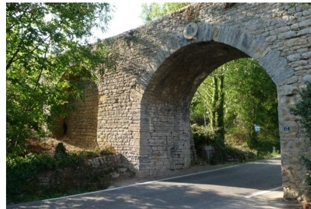
Bien en amont du tracé de l'aqueduc, le mur-canal antique percé pour la création de la route de Saint Fortunat vers 1840 et transformé à l'occasion en viaduc
