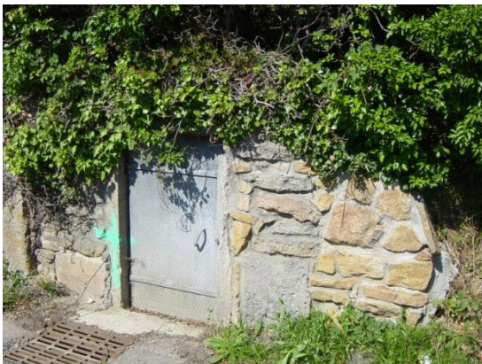
Le puits des Vignes sur la rocade de Monts d'or . Cette galerie alimentait le canal du pont du vallon d'Arche
