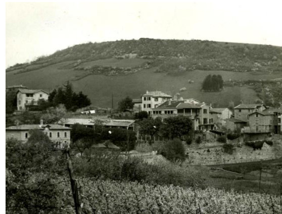
Au centre de la photo l'Aérium de Saint Fortunat et son préau
