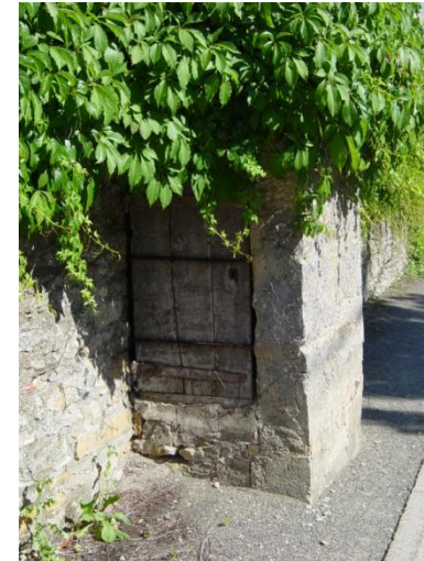
Le puits de Cusson, av . G Péri
