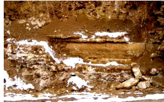
Coupe de l'aqueduc au Chemin de l'Indiennerie. On distingue au centre le mortier de tuileau concassé du canal ainsi que la couverture de lauzes. Un radier supporte le tout.
