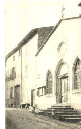
Façade de la chapelle en 1909
